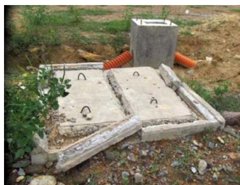
Bảng mắt thường cũng có thể nhận thấy chất lượng thi công hệ thống thoát nước không đảm bảo.
