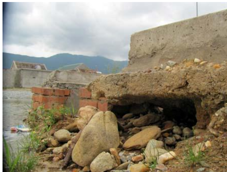
Sau trận mưa mới đây bờ taluy một tuyến đường tại Khu TĐC xã Kỳ Long bị nước cuốn trôi để lộ rõ những mảng đất, sỏi.
