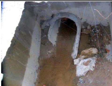
Taluy lở lói, ống nước vừa làm đã vỡ nát.
